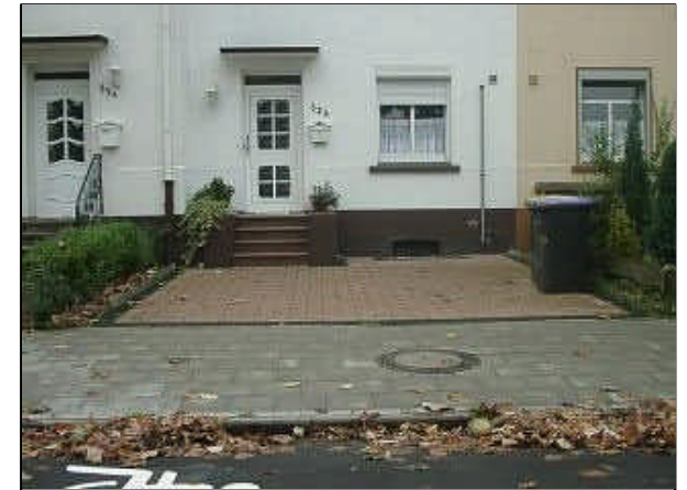
Unzulässig: Versiegelung der Vorgärten
