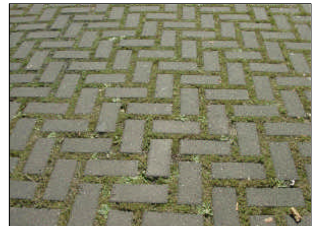
Rasenfugenpflaster als mögliche Befestigungsart für Garagenzufahrten
