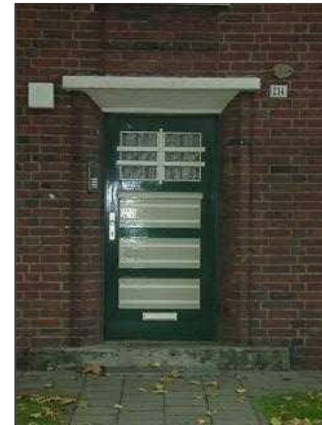
In ursprünglicher Form erhaltene Haustür
