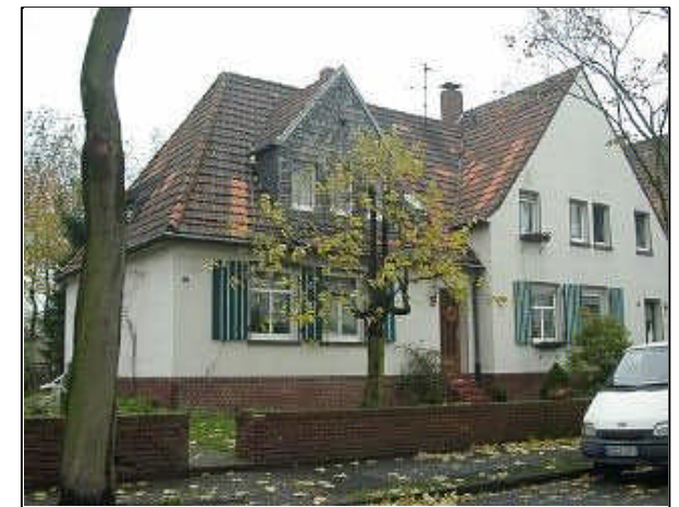
Ursprüngliche, charakteristisch ausgebildete Fassadengliederung
