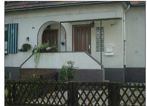
links: Ursprünglich ausgebildeter Eingangsbereich (Loggia), der zu erhalten ist.
