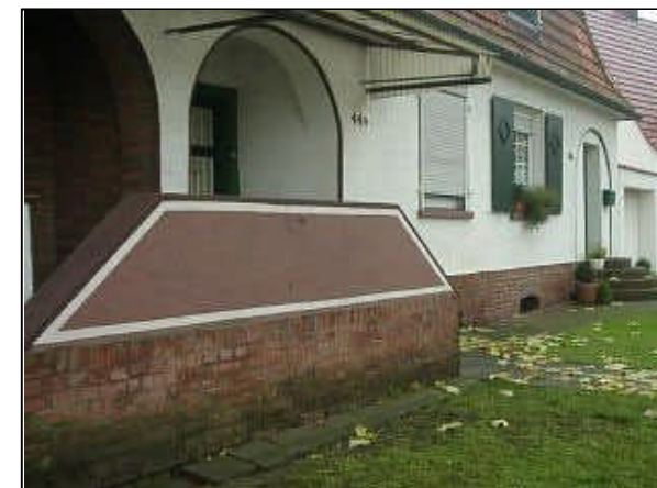
Gemauerte und verputzte Brüstungen mit braunem Anstrich sind zu erhalten.
