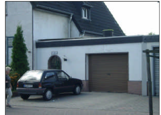
Unzulässige Errichtung von Mauern zwischen Wohnhaus und Garage
