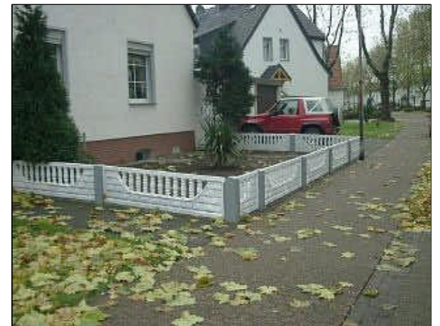
Unzulässiger Balustradenzaun aus Betonfertigteilen
