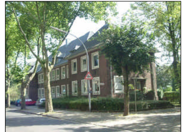
Zu den „Besonderen Einzelgebäuden“ zählt auch das Gebäude des Kindergartens an der Kattenstraße.
