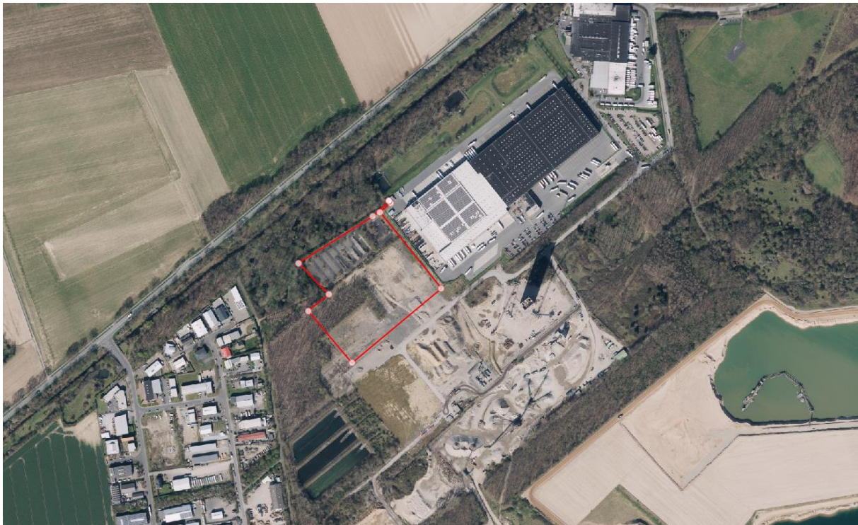
Abbildung 8: Luftbildaufnahme des Plangebiets und der weiteren Umgebung
