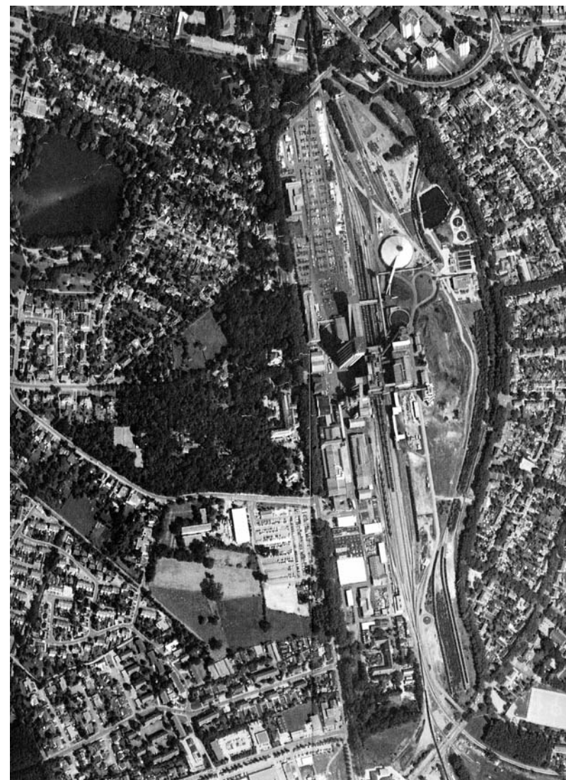
Bergwerk West – Luftbild Stadt Kamp-Lintfort
